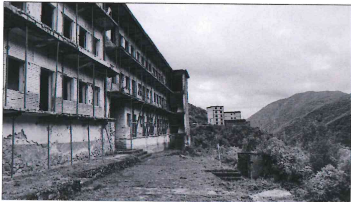
Foto te gjendjes ekzistuese
